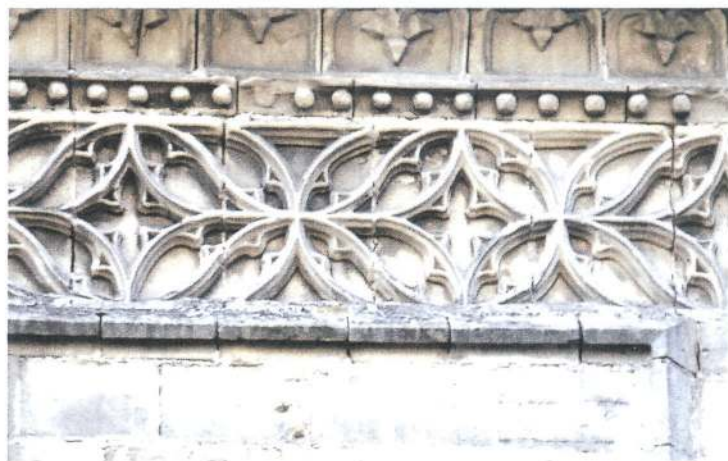
41. Ifarraldeko erremate flamigeroak. Detallea.
