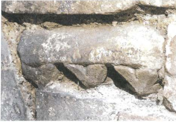
7. Erromaniko arku zatia elizaren hegoaldeko hormaren oin partean. 7. Fragmento de arquivolta románica en la base del muro meridional de la iglesia.
